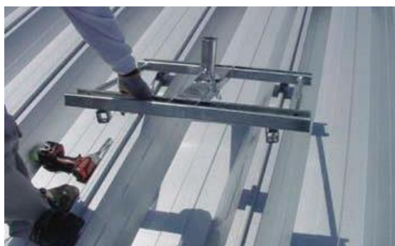
① 支柱ベースを仮置きする。その時にハゼ金具のナットをインパクトレンチで緩めておく。
