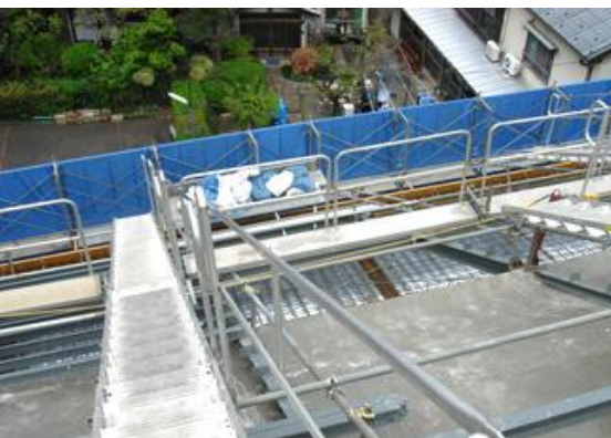
建築屋根部打設用・昇降用に設置
