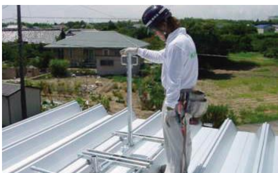
⑤ 支柱を支柱ベースの中央ソケット部に差し込む。
