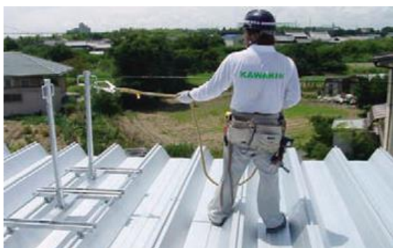
⑦ 親綱のフックを支柱の取付ベースに掛ける。
