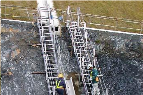
砂防流路工事に使用（昇降及び作業足場）
