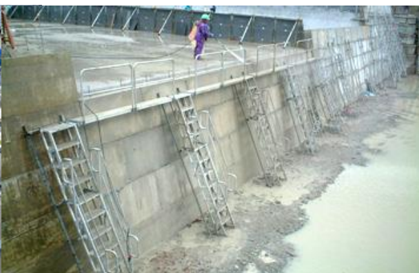
砂防ダムPC版仮受用足場として使用 横つなぎの足場セット可能
