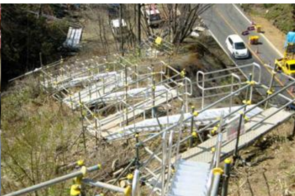
作業員の昇降用通路として設置
