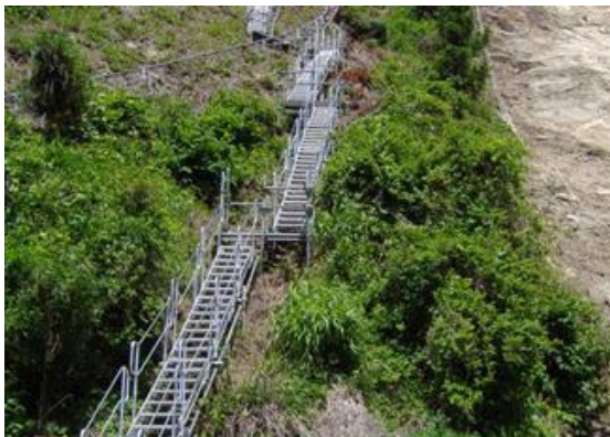
従業員の昇降用通路として設置
