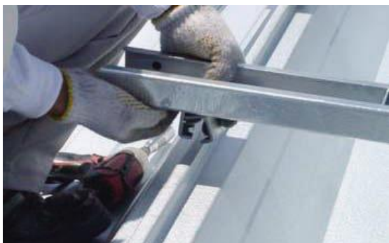
③ ハゼ金具の口を広げて、ハゼ部に咬ませるようにセットする。(ハゼ金具4ヶ所)
