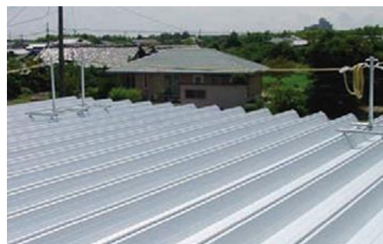
⑧ 親綱を取付け、緊張器を用いて、概ね水平になるように緊張して完成。
