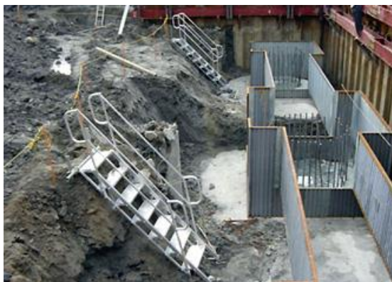
盛土工事の落差の昇降設備として使用
