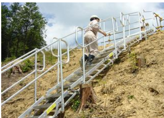
作業員の昇降用通路として設置
