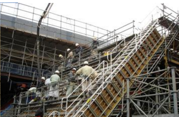
跨道橋アバット部の足場兼昇降設備として使用
